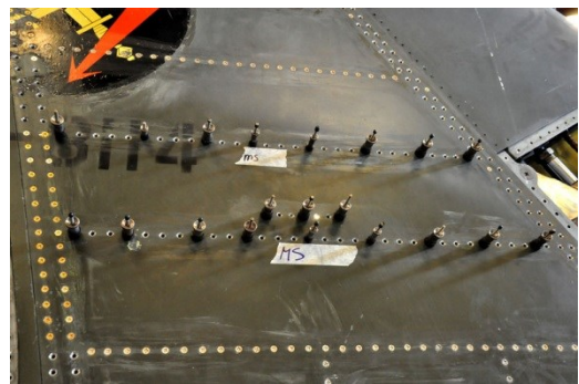
Hier moeten de jo bolts nog geplaatst worden
